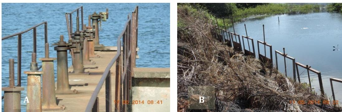
Figura 25 - Sistemas de controle por guilhotinas já depreciados pelo tempo.
