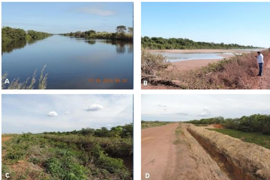
Figura 44 - Degradação ambiental dos canais de irrigação. Em (A), Adutora Principal Formoso, sem revestimento, com 90m de largura e 1500m de comprimento; Em (B), assoreamento do canal por sedimentos; Em (C), assoreamento por sedimentos e crescimento da vegetação no canal; Em (D), abertura de vala paralela ao canal preenchido por vegetação.
